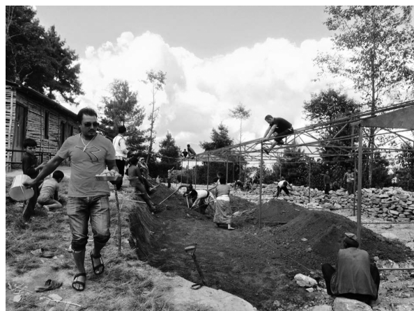
地震復旧支援事業 (学校建設)
